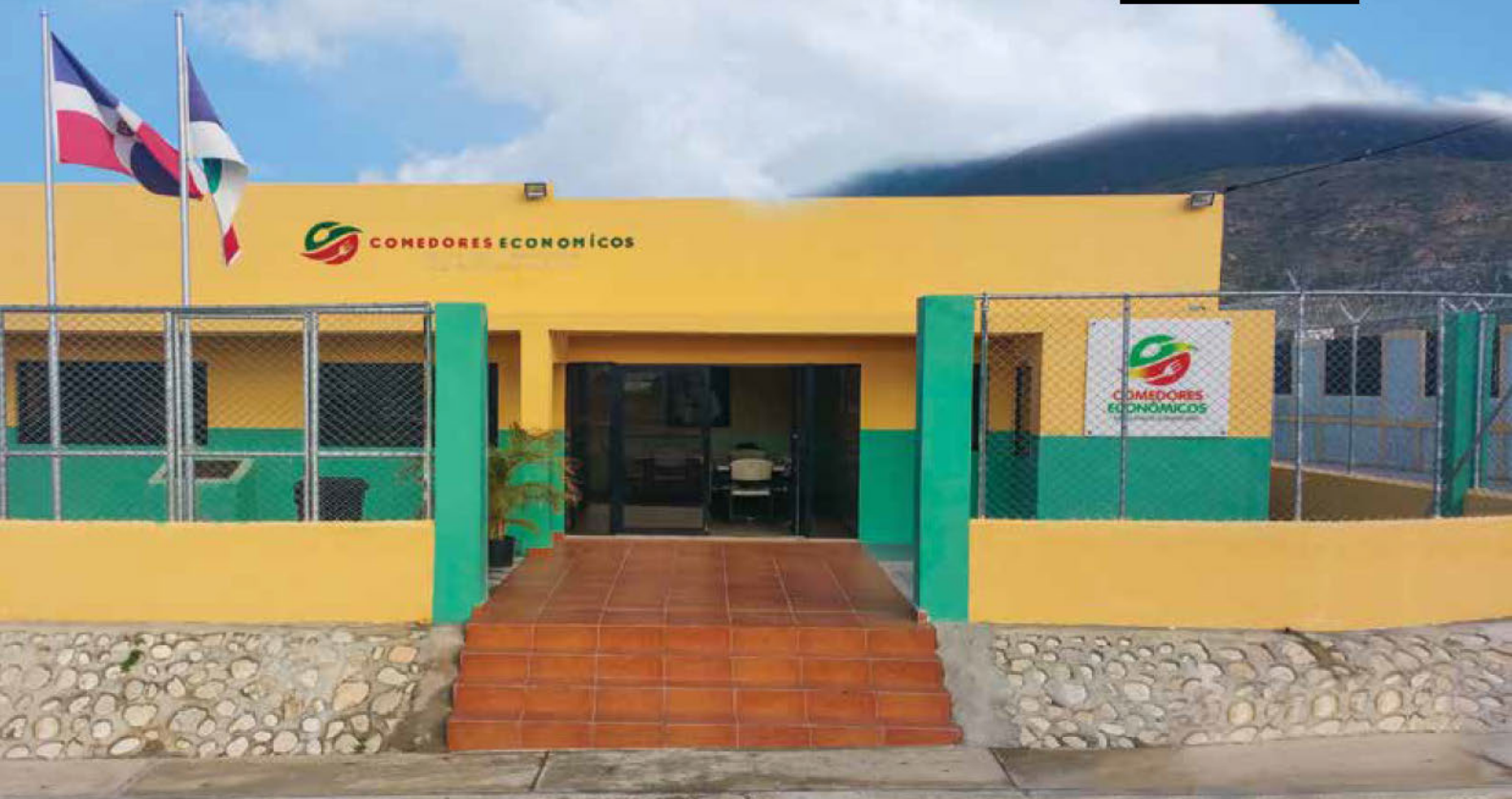
Fachada frontal del comedor de Boca de Cachón
